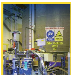
L'ipoclorito di sodio provoca problemi di blocco da gas in molti altri tipi di pompe
