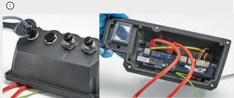
Afbeelding 10 - Aardingsscherm voor besturingskabels op de EtherNet/IP™ NEMA module
